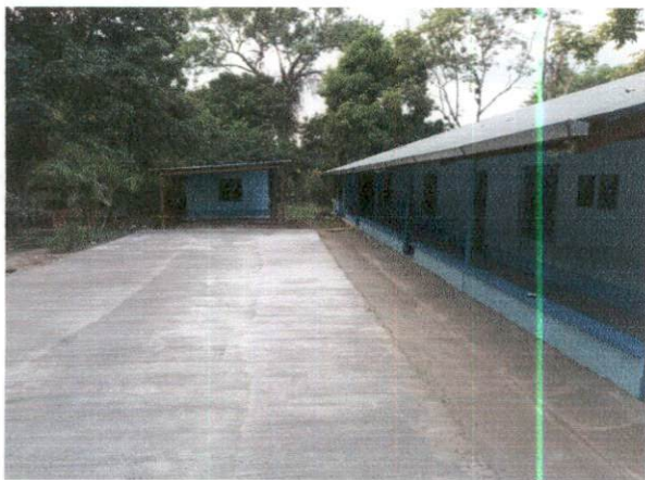
Foto1: REMOZAMIENTO DE CANCHA FINALIZADA
