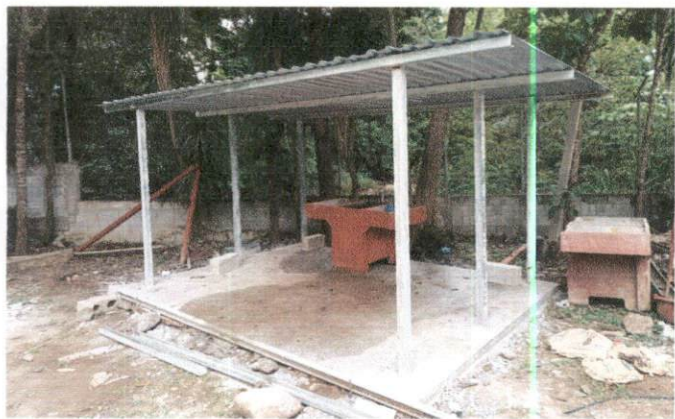
Foto 3: REMOZAMIENTO DE GALERA FINALIZADA
